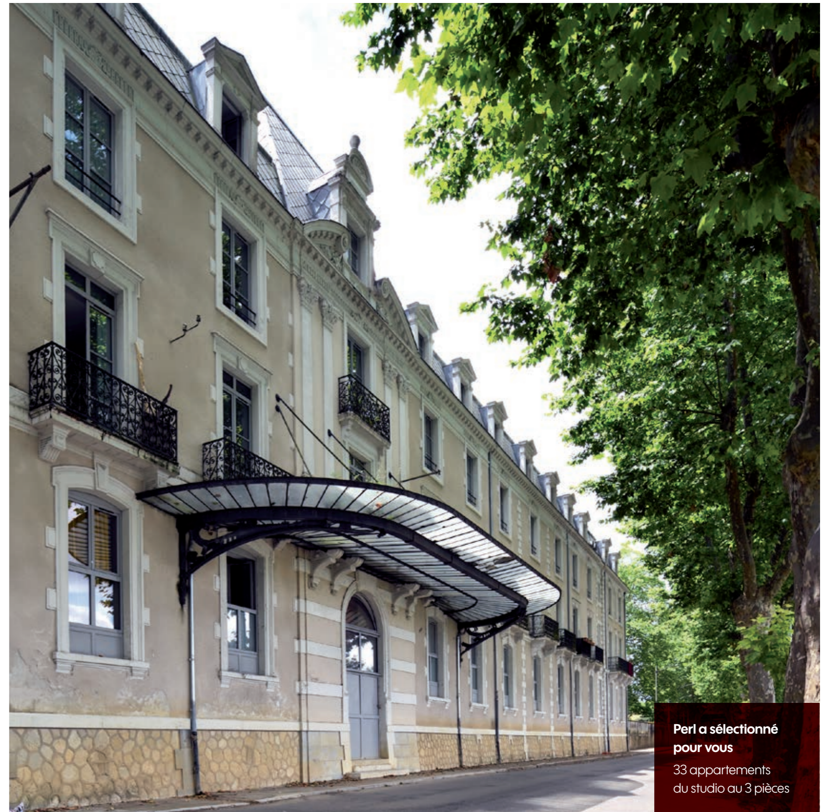
La façade de "Résidence des Baignots"
